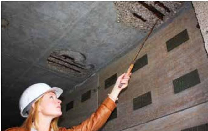
Abplatzungen des Betons an der Unterseite der Gruftdecke.
